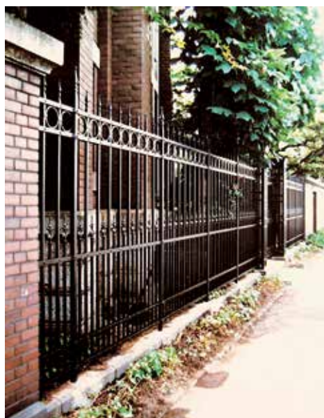
埼玉県 川口市 旧田中家住宅
