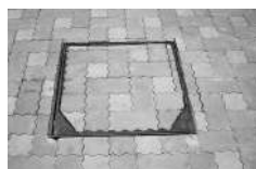
①設置状態
