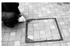
②ふたのゴム栓をドライバーで はずします。
