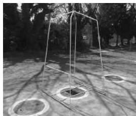
②テントフレームを組立て、テントベースの筒に乗せます。
