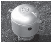
⑧ゴムキャップを取付け完成
