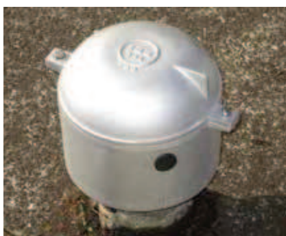
⑧ゴムキャップを取付け完成
